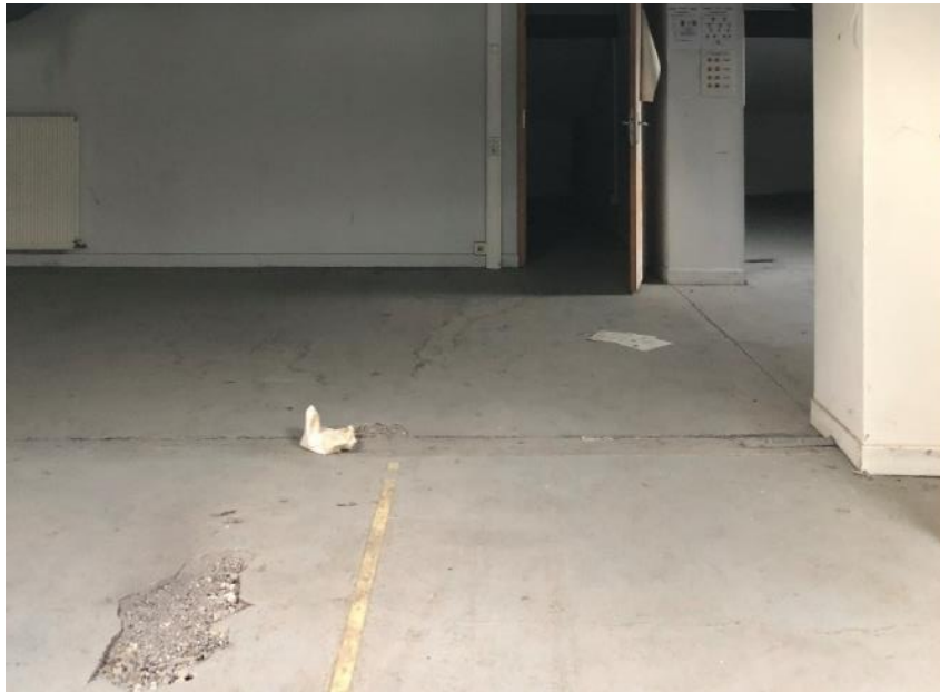
Figure 9 : Plancher bois recouvert s'une chape béton - PB R+3
