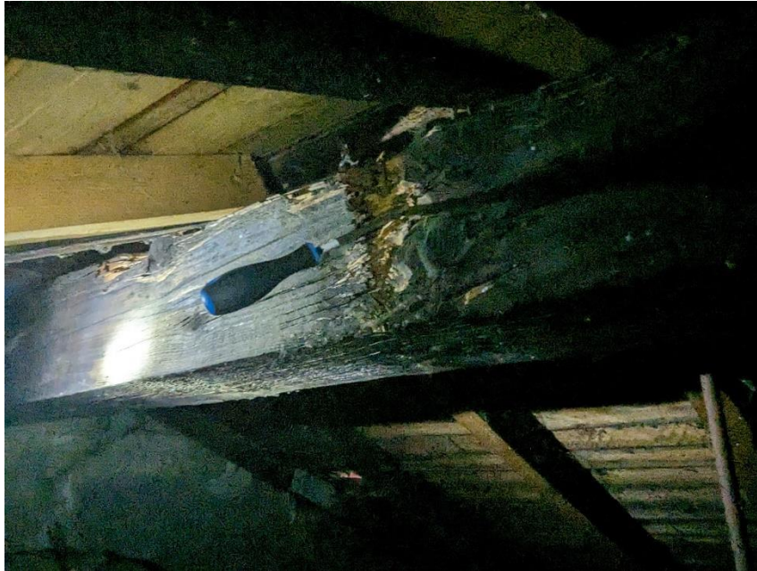
Figure 7 : Faîtière dégradée en zone Nord
