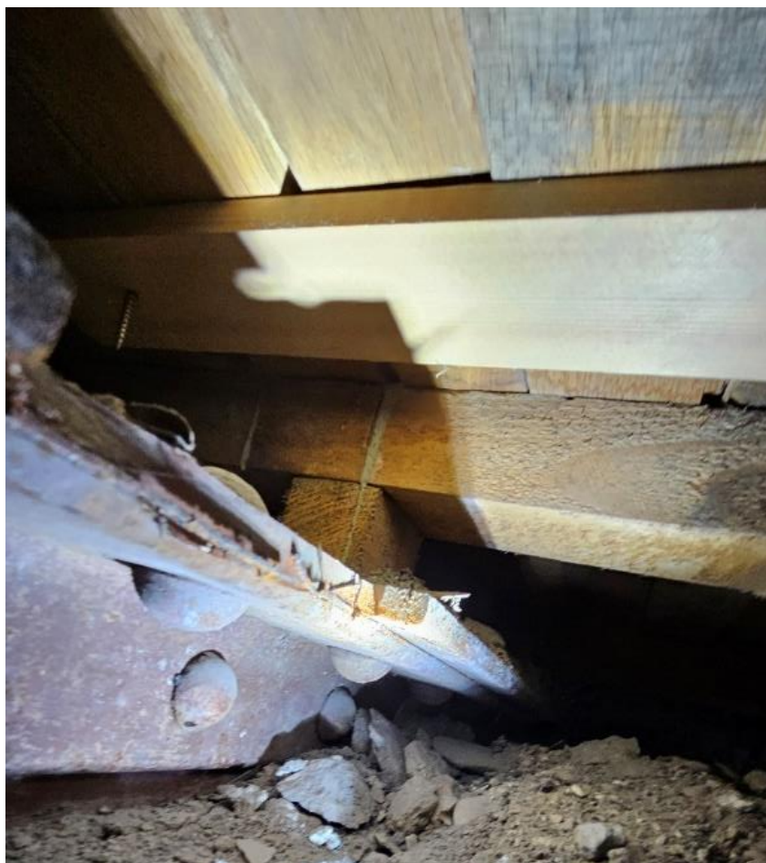
Figure 10 : Profilé riveté dont l'aile supérieure a été meulée sur plus ou moins 20 cm
